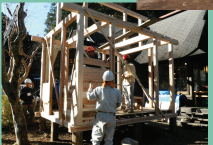
⑤ログハウスの施工
